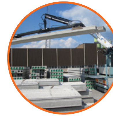
Handling van betonnen vloeren
