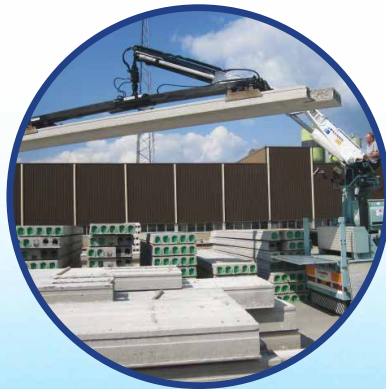
Handling van betonnen vloeren
