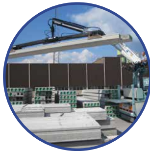
Handling van betonnen vloeren
