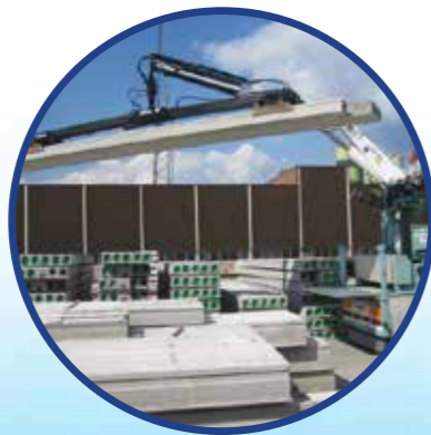
Manutention de planchers en béton
