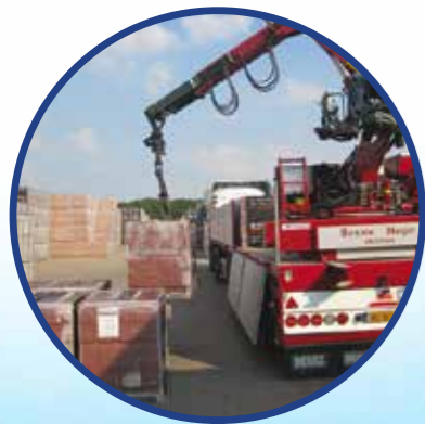
Manutention de briques et de blocs
